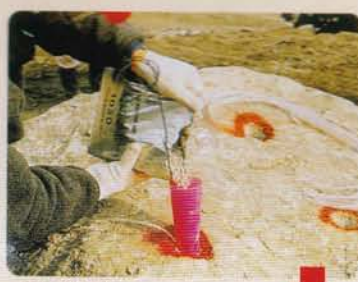
充填作業 スティック充填法
